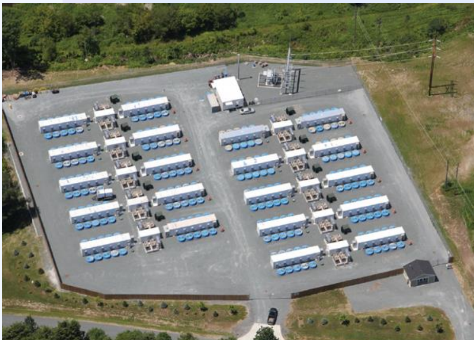
FOTO: Planta de almacenamiento de 20 MW basada en 200 volantes de inercia de 100 kW cada uno. New York ISO.
